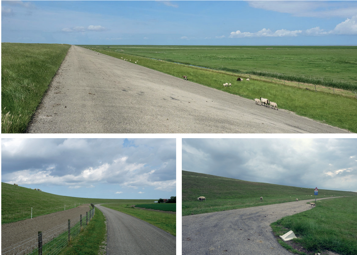
FIGUUR 17 IMPRESSIE VAN DE POLDIJK IN FRIESLAND
