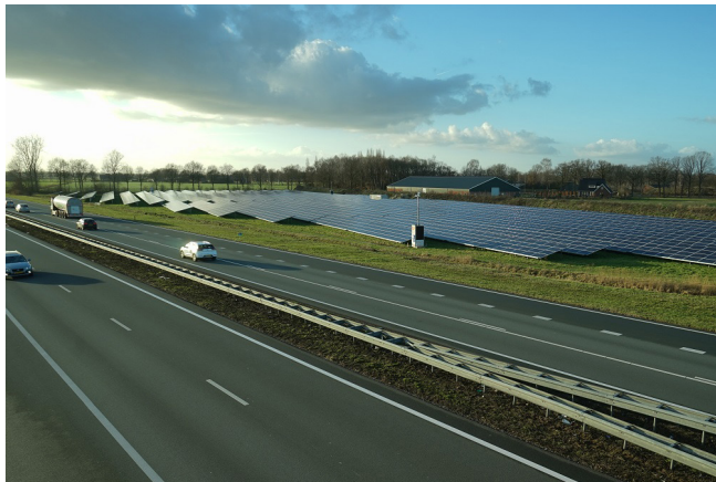
Bestaande panelen A50 bij Veghel noord
