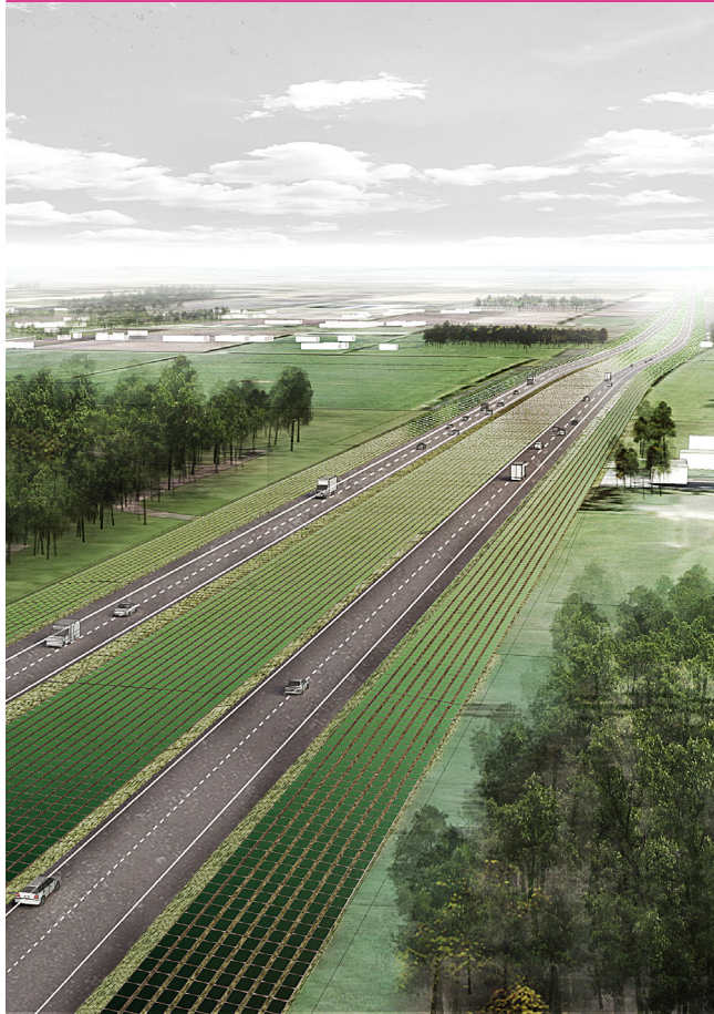
Energiebermen aaneengesloten lijn van panelen (Zonneroute A37)
