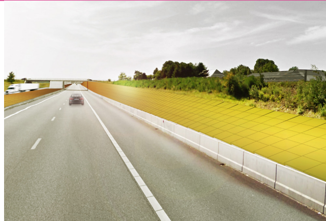
Energieberm loopt op richting viaduct (Zonneroute A37)
