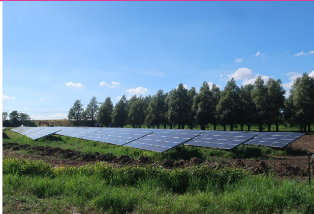
Zonnepanelen langs de N31, aansluiting Wergea
