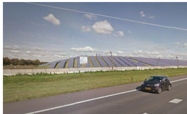
Bestaande panelen op oude vuilstort aan de A15 bij Geldermalsen
