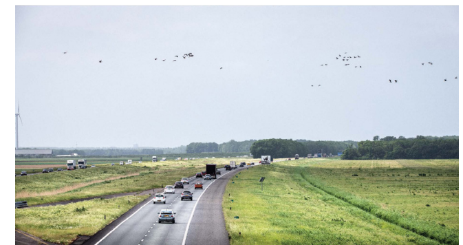
Dwarsprofiel A6 met afwisselend beplante midden- en buitenbermen (RWS studie Zonnepanelen A6)
