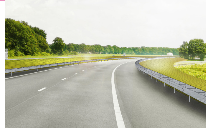
Panelen op flauw talud boogstraal A37 (Zonneroute A37)
